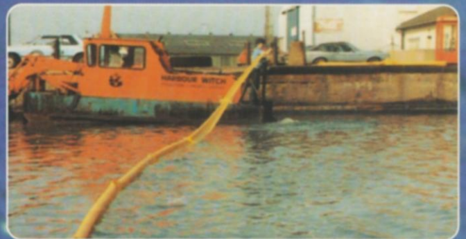
塑料充气管式拦河坝
